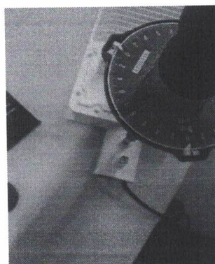
Parafusos suporte de fixação ao poste
