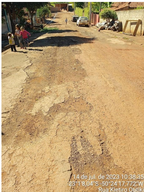
Imagem 07 - Rua Kietiro Outiki
