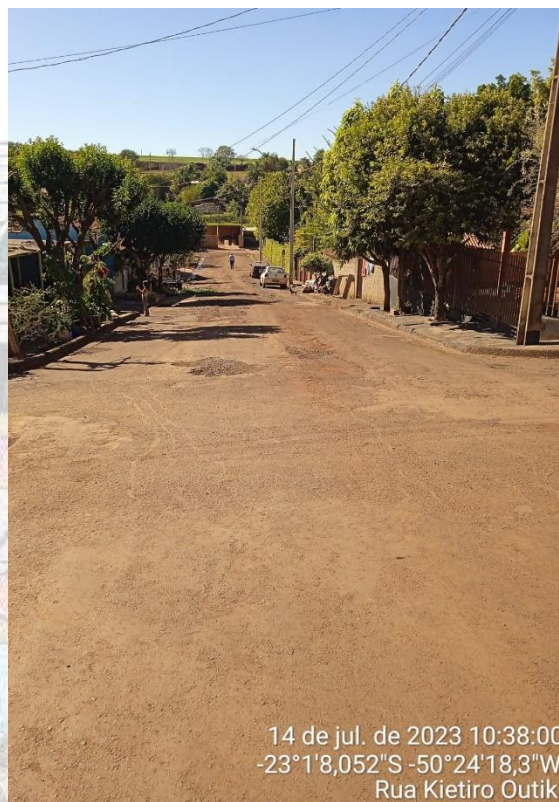
Imagem 08 - Rua Kietiro Outiki
