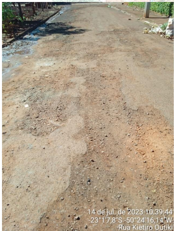
Imagem 05 - Rua Kietiro Outiki
