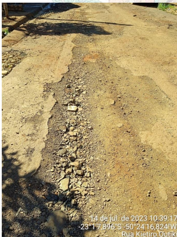
Imagem 09 - Rua Kietiro Outiki
