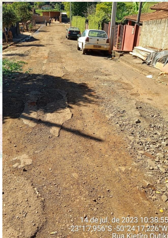
Imagem 06 - Rua Kietiro Outiki
